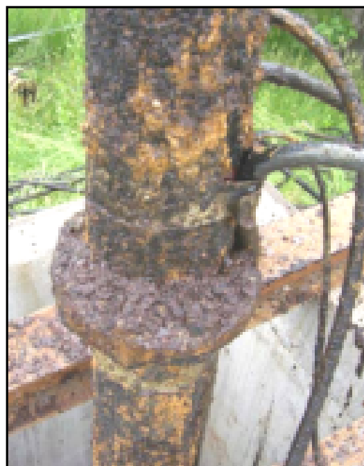
写真 - 2 引き上げ直後の既設揚水管
