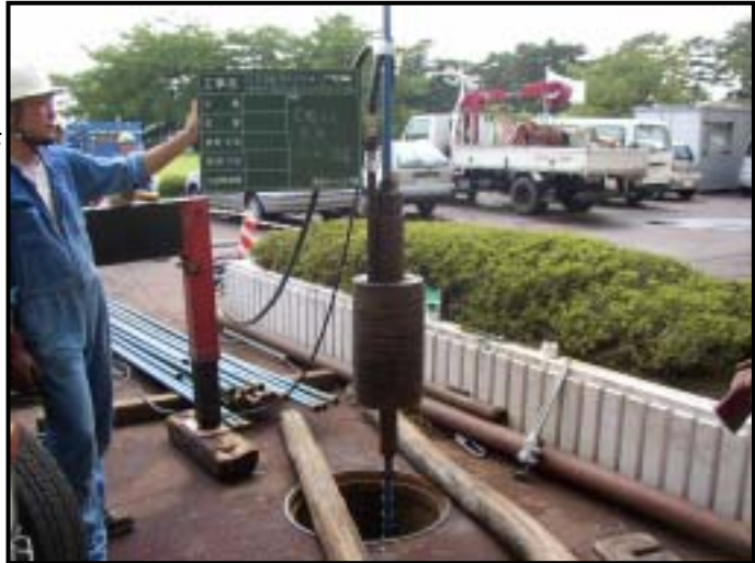
アクアフリード工法に使用するパッカーを井戸に挿入 (白百合女子大学 1号井戸にて)
