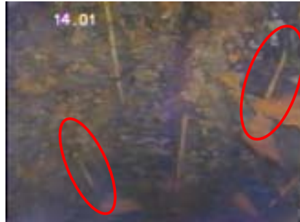
アッフルード工法施工後
